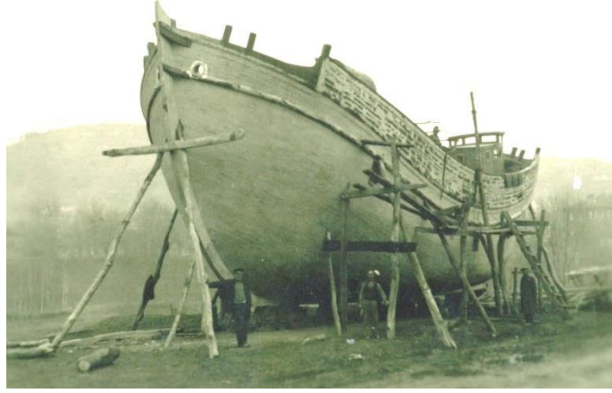
Şekil 14. VANLI gemisi Bartın'da inşa halinde 1965.
